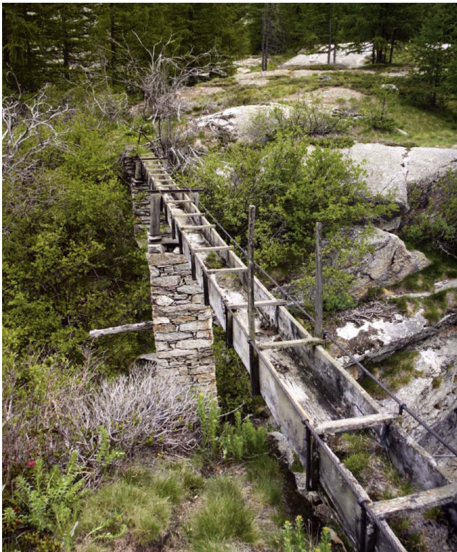
Fig. 6: Ru de Chené, irrigation canal, (Valsavarenche).
